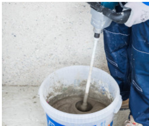
Mezcla de Planitop Rasa & Ripara R4 Zero
