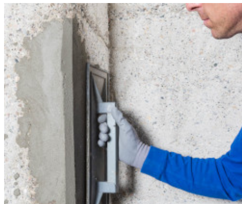
Fratasado de Planitop Rasa & Ripara R4 Zero
