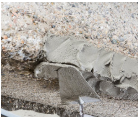
Aplicación de Planitop Rasa & Ripara R4 Zero
