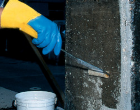
Extensión de MapeWrap 31 con rodillo, sobre una capa de MapeWrap 11 (o MapeWrap 12) aún fresca
