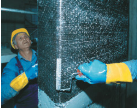
Presión ejercida sobre el tejido con el Rodillo para MapeWrap, para hacer penetrar MapeWrap 31 en el tejido
