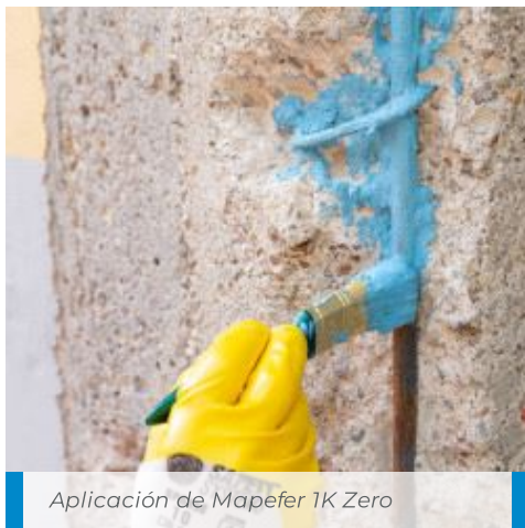
Aplicación de Mapefer 1K Zero sobre barras de refuerzo de un viaducto.
