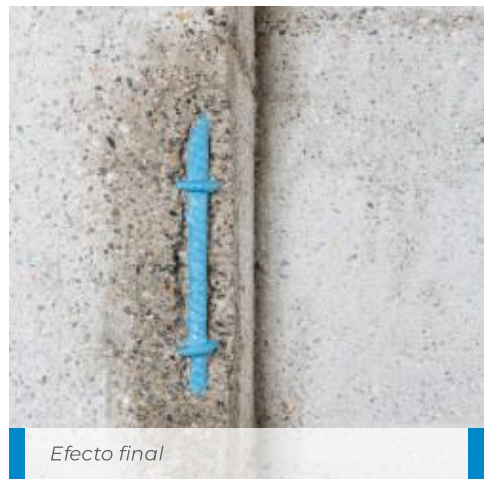
Aplicación de Mapefer 1K Zero sobre barras de refuerzo de un viaducto.
