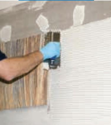
Aplique el mortero en una sola dirección con el lado dentado de la llana
