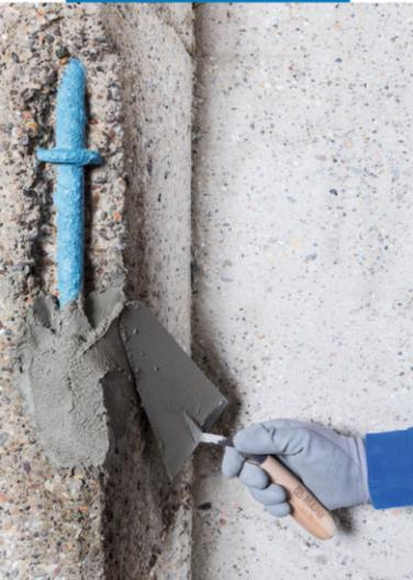
Aplicación de Planitop Rasa & Ripara R4 con cuchara de albañilería
