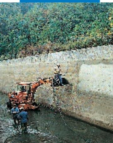
Aplicación por proyección de Planiseal 88 en un canal hidroeléctrico
