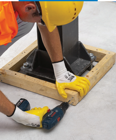
Montaje y montaje de encofrados antes de verter mortero
