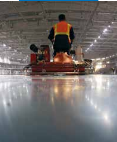
Piso de concreto reforzado con Mapefibre ST 42
