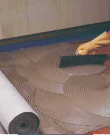
Aplicación de la primera capa de Mapelastíc, y la colocación sucesiva de Mapetex Sel
