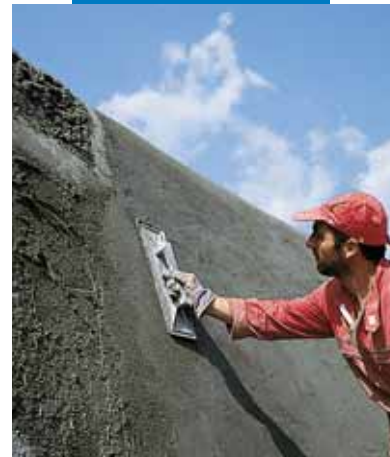
Acabado fratasado Mapegrout T40
