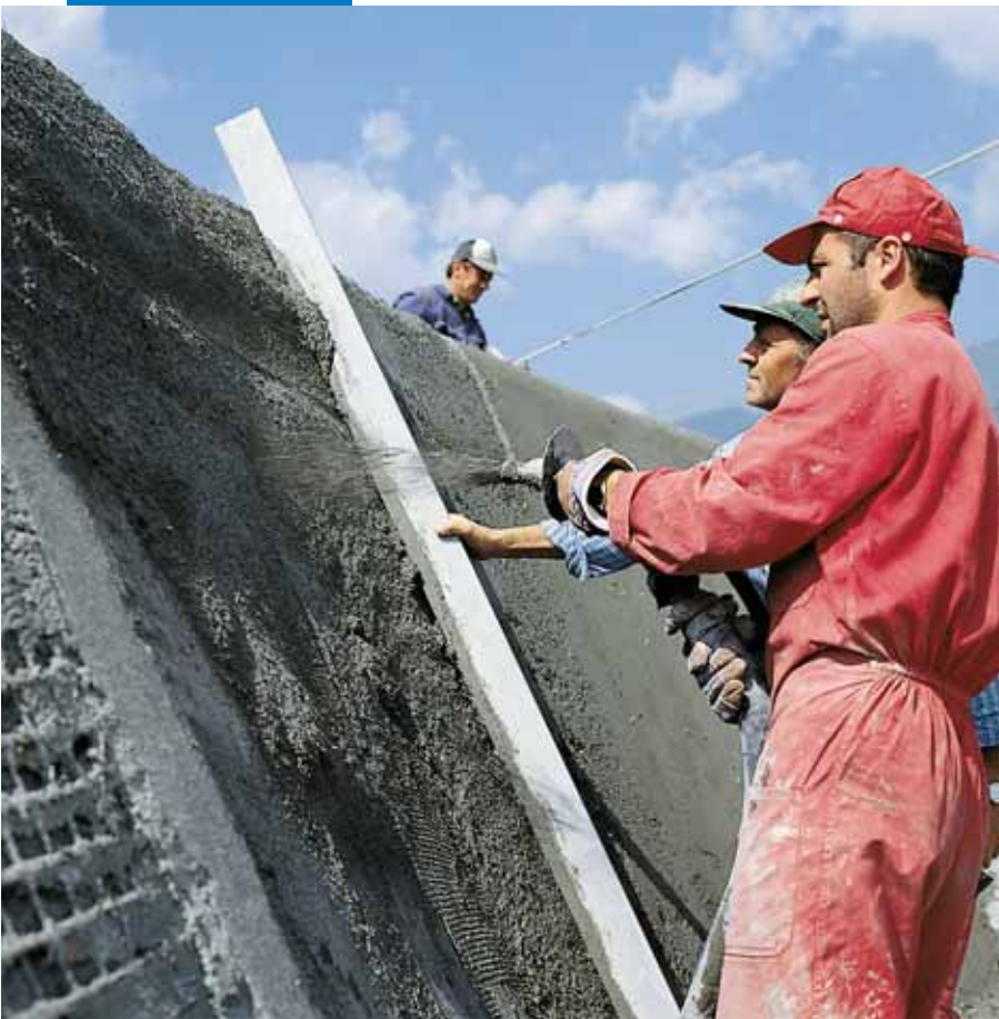
Aplicación de Mapegrout T40 con máquina de revocar
