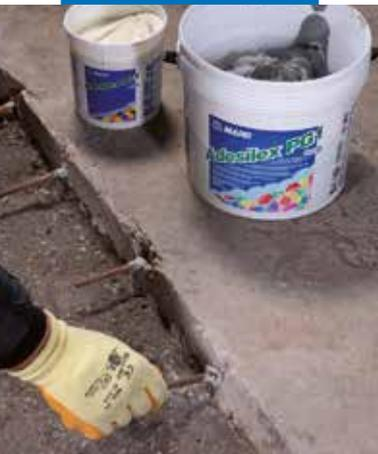
Fijación de las armaduras para el enclavijado con Adesilex PG1
