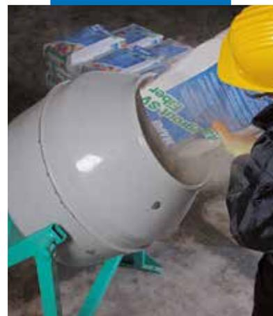
Preparación de la mezcla de Mapegrout SV Fiber
