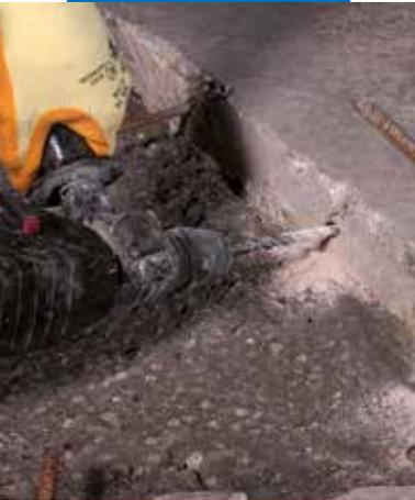
Preparación de los agujeros para la inserción de armaduras de enlace (enclavijado)
