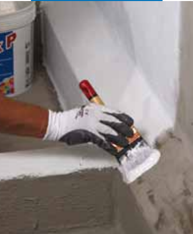
Aplicación con brocha de Triblock P sobre soporte húmedo
