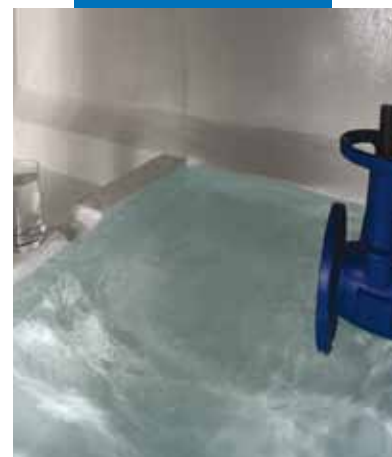
Llenado de un depósito después del endurecimiento completo de Mapecoat DW 25
