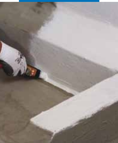
Aplicación de Triblock P sobre la unión entre el suelo y la pared
