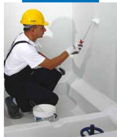
Aplicación con rodillo de Mapecoat DW 25
